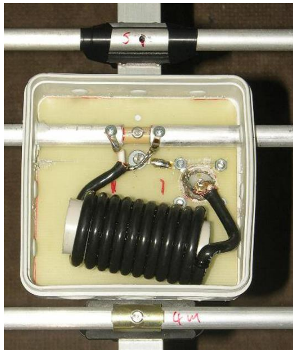
Fot. 3.1.2. Zasilanie anteny trzypasmowej
